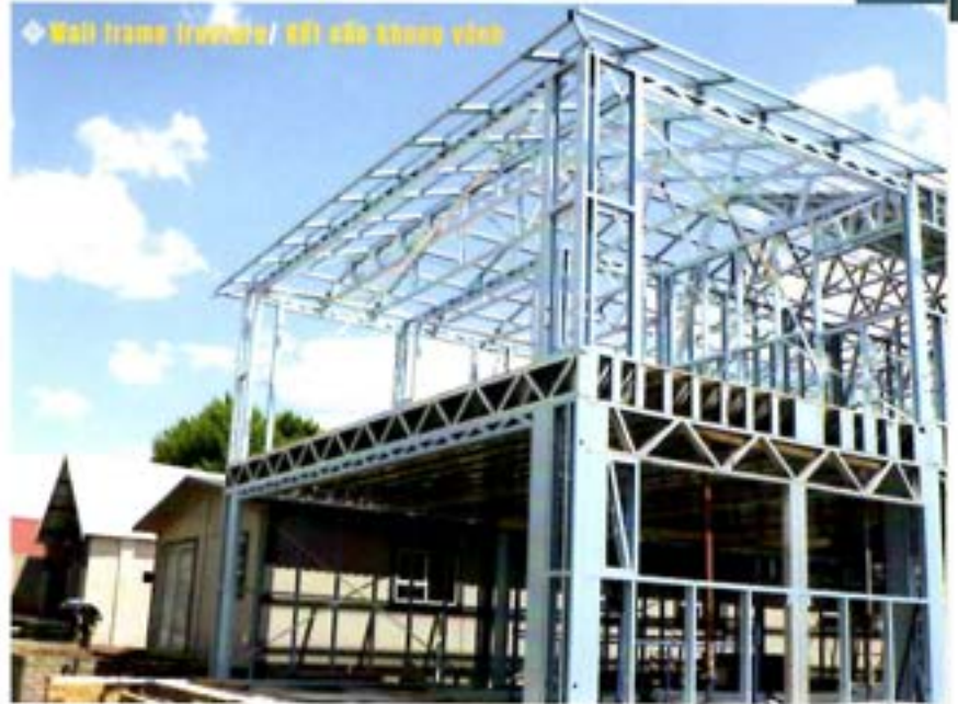
◆ Roof frame structure / kết cấu khung mái
